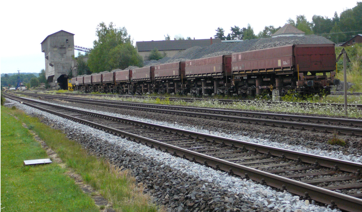
Verladeanlage am Bahnhof Pechbrunn
